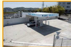
【水素サプライチェーン】 2002 水素ステーション建設の 取り纏め工事の 初受注
