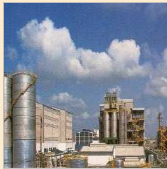
▶ ケミカルプラント建設
